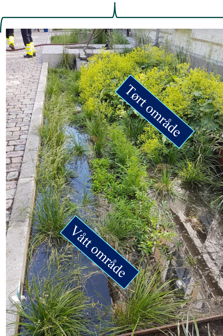
Observert skjev jordoverflate i regnbed 7
