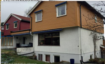
Bilde med 3 frakoblede takreiner
