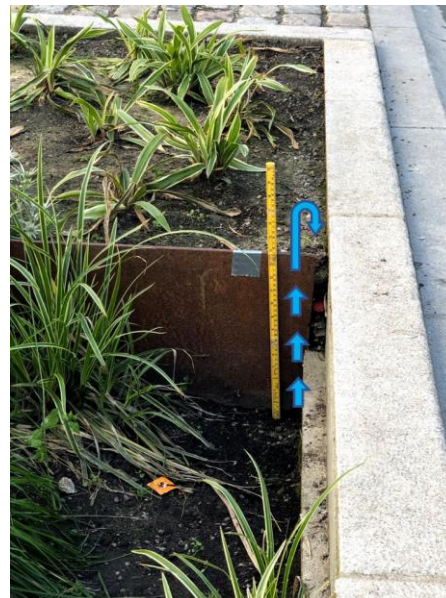
Observert skjev jordoverflate i regnbed 7
